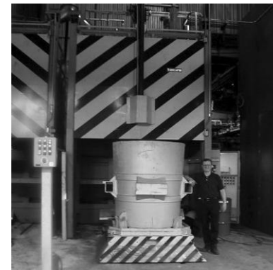
Станция обработки ковшей порошковой проволокой. Объем ковша 16 т.
